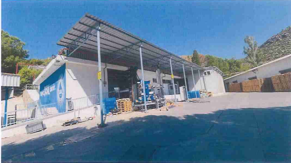
Kapama ve ilave çatı eklemesi yapılacak olan alan
